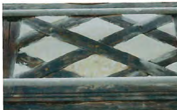
Bei den Vorarbeiten wurden „Fünferkreuz-Gefache“ freigelegt, die vorher überputzt waren. Diese Fachwerkfigur verrät die Entstehungszeit zwischen 1790 und 1810
